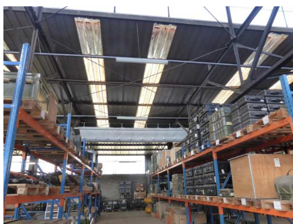
6 - Présence de plusieurs poutre au vent dont une à chaque extrémité du bâtiment.
