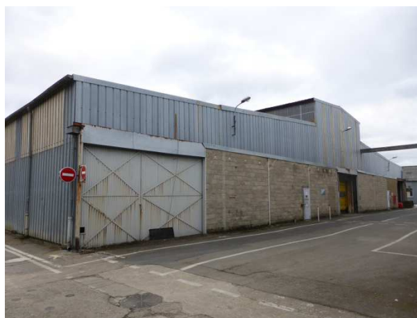
4 - Appentis de rive. Pas de présence de lien de maintien hors plan des pannes ni de contreventement
