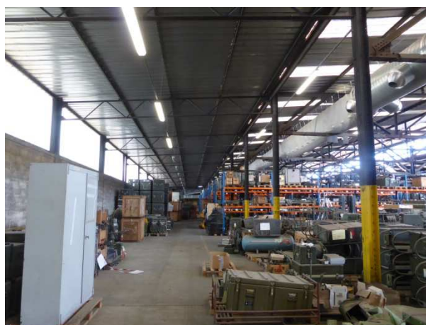
6 - Présence de plusieurs poutre au vent dont une à chaque extrémité du bâtiment.
